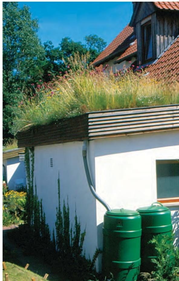
**Vorbildlich: Das Dach des Anbaus ist begrünt, und überschüssiges Wasser vom Dach wird in Regentonnen aufgefangen – da geht kein Tröpfchen verloren**
